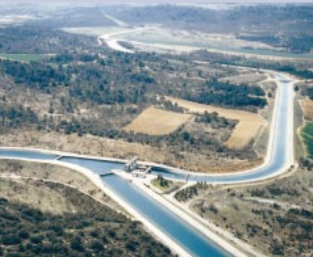
Le Canal de Provence dans le Var : bétonné et protégé des ruissellements, il préserve la qualité de l'eau provenant du Verdon qui prend sa source à 2 240 m d'altitude, DR.
