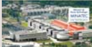
Maitre d'ouvrage : conseil général de l'Isère ; maitre d'œuvre : Groupe 6 ; bureau d'études : Setec.
