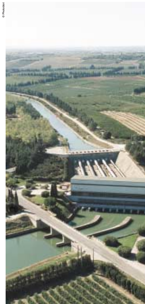
Station de pompage sur le canal Philippe Lamour.
