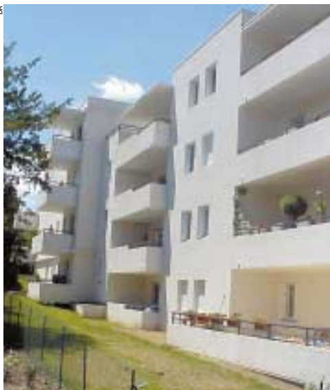
Opération Tibériade (façade sud).
